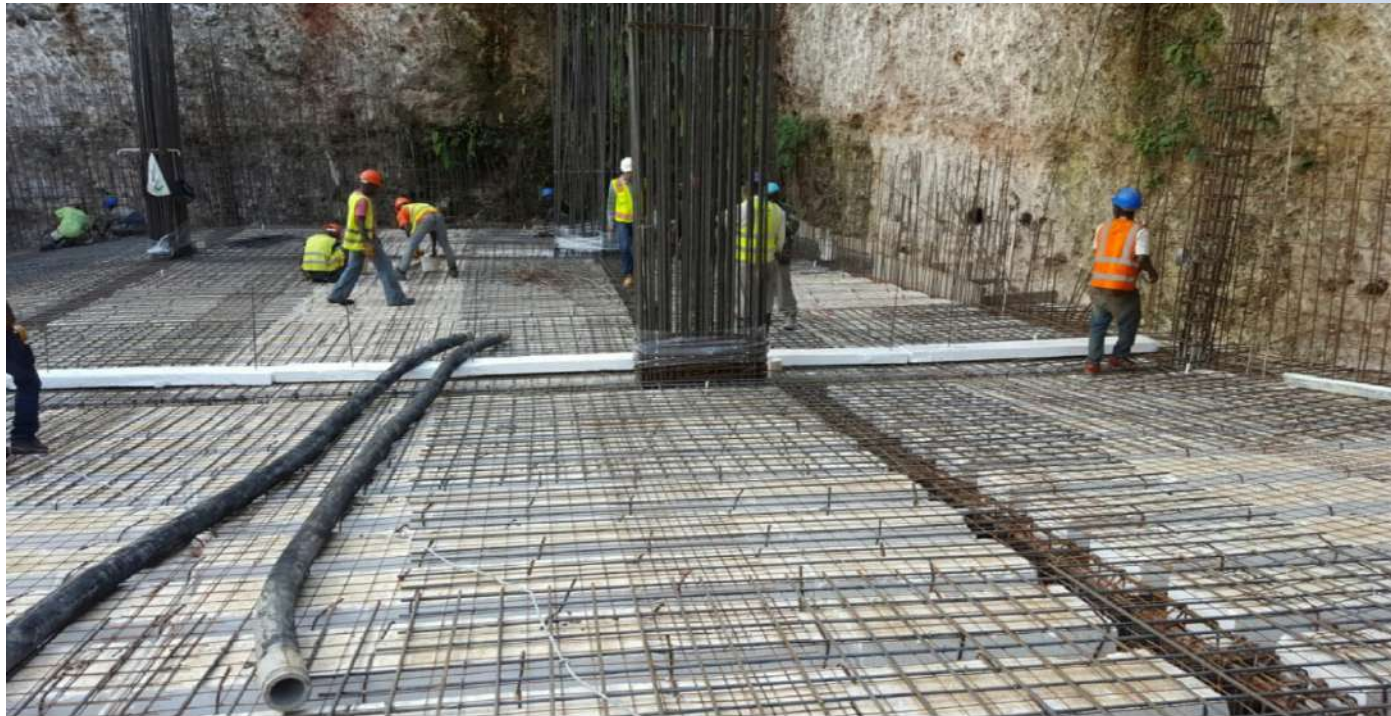
Foto 3: Proceso de construcción Parques Edificación en Sector Naco, Santo Domingo, D.N:
