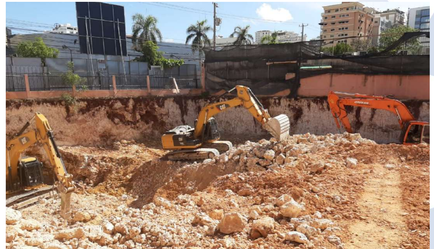
Foto 2: Excavación de una obra actual en Santo Domingo, D.N:
