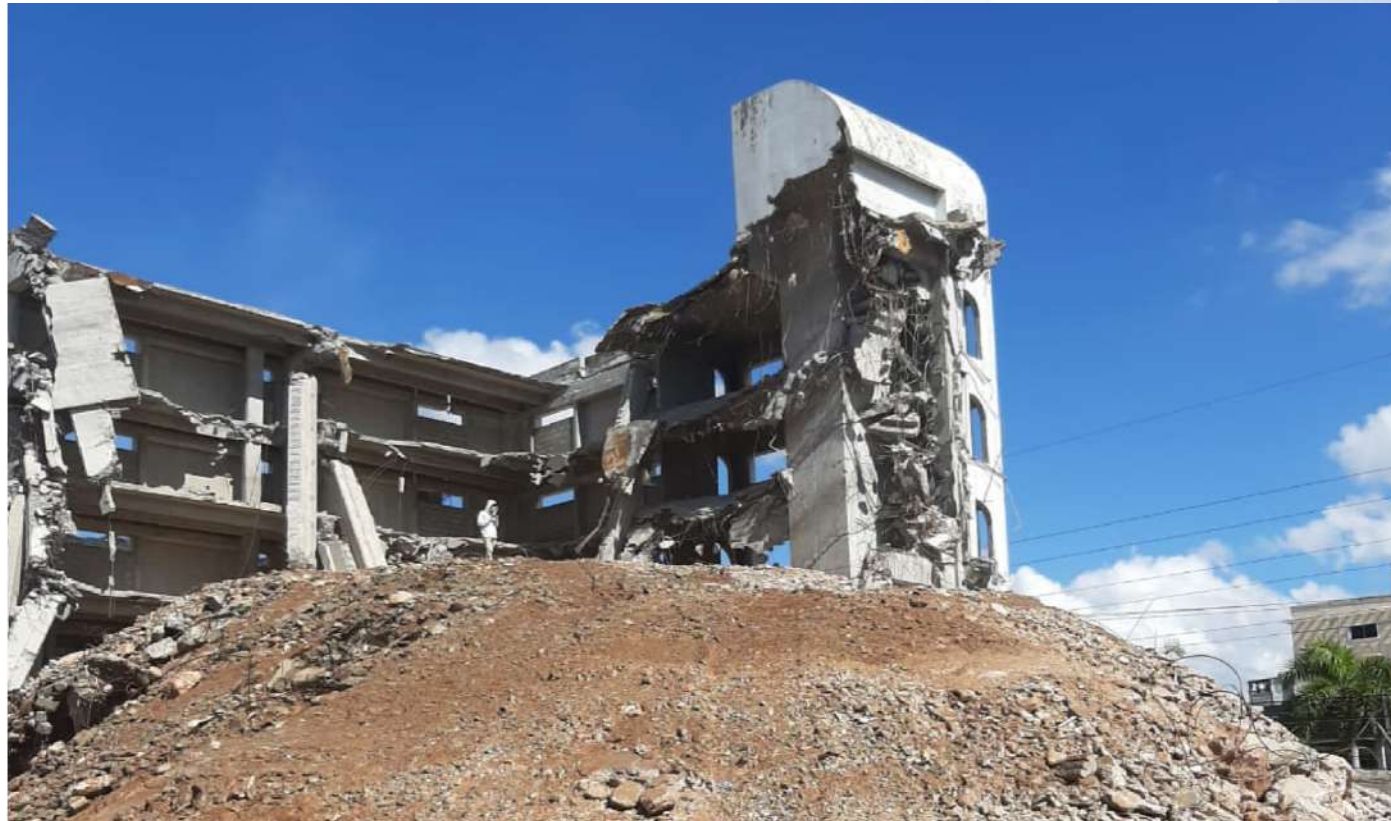
Foto 1: Proceso de demolición de edificación existente en Santo Domingo, D.N
